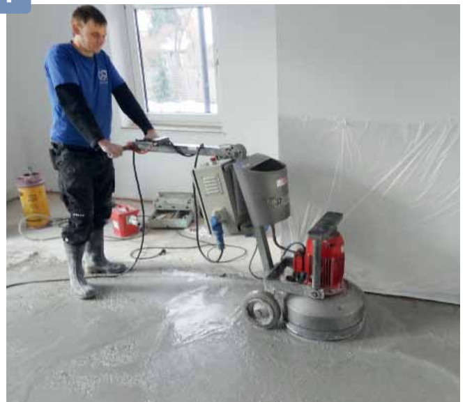
Mit Hochleistungs-Schleifmaschinen ist heute vieles möglich, was noch vor Jahren unwirtschaftlich gewesen wäre. Vorausgesetzt, der Sanierer ...
